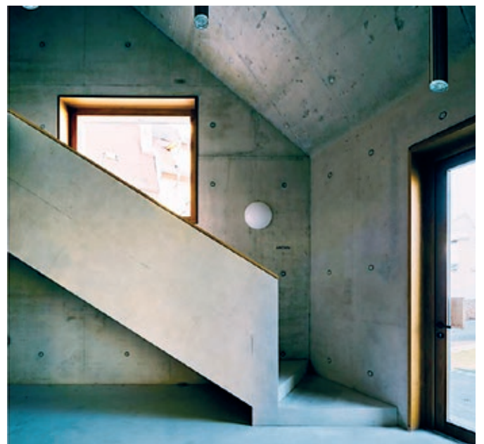
Im Innern dominieren rohe Betonwände - eine Brandschutzmaßnahme, die auch half, im Kostenrahmen zu bleiben.
