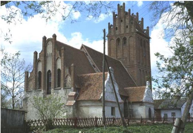
Die klassische Vorderansicht der Patronatskirche in Mühlhausen nach ihrer Hauptinstandsetzung im Jahr 1996.
