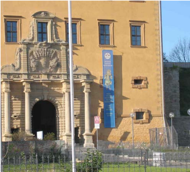
Ansicht 2 (Ansicht Torhaus von der Strasse aus)
